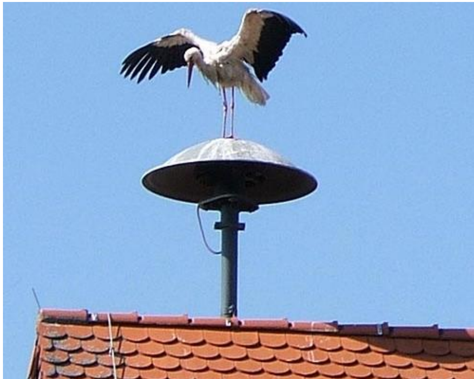
Bild 1: Eine elektromechanische Sirene (Motorsirene) des Typs E57 – hergestellt von HÖRMANN in den 1950er Jahren
