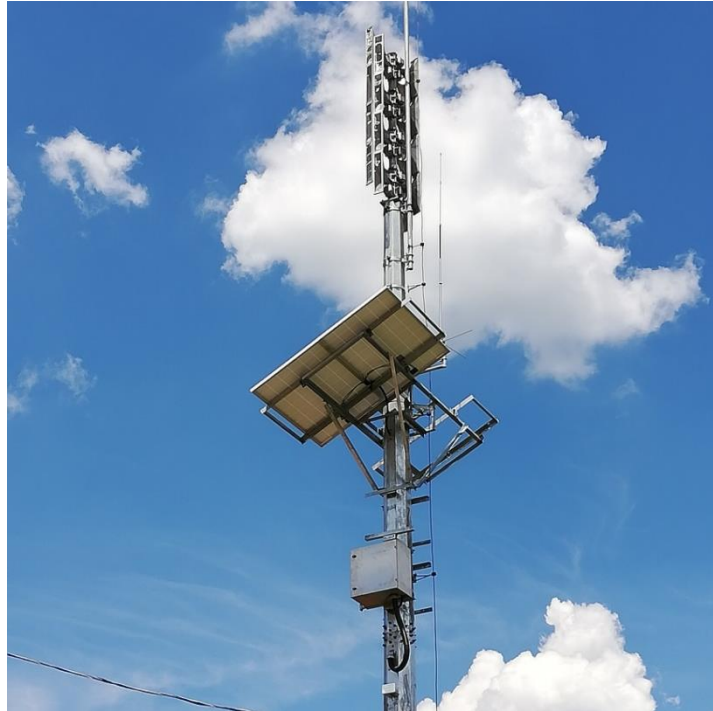
Bild 4: Elektronische Sirene mit Solarmodul
